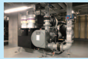
地域冷暖房プラント
